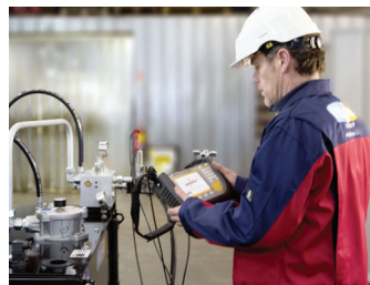
Opération de maintenance sur centrale hydraulique.
