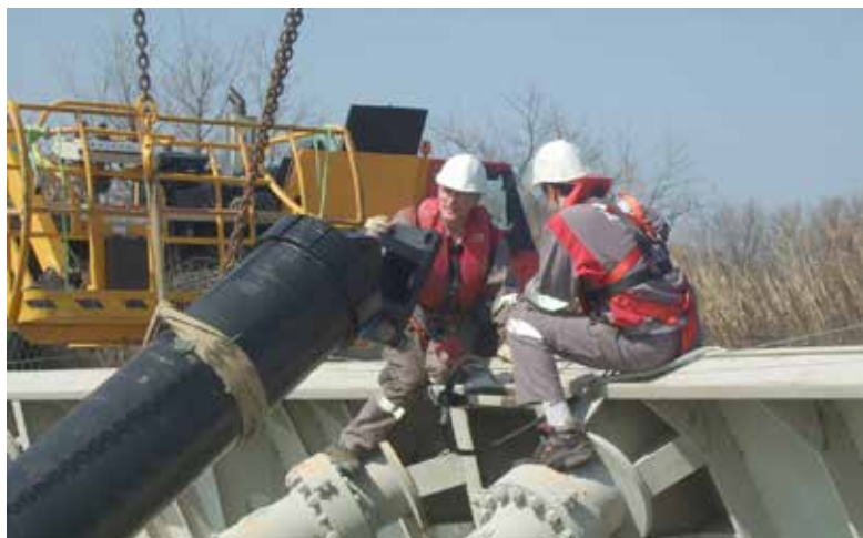
Réparation de vérins hydrauliques sur site.
